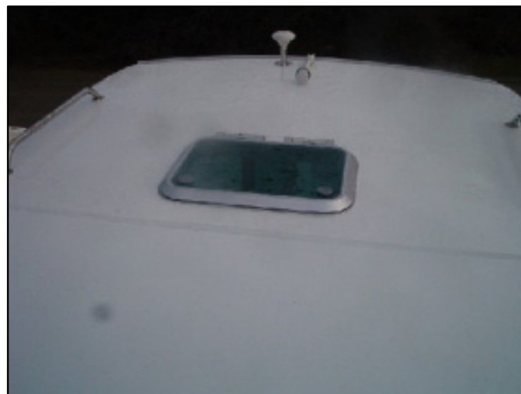
PANNEAU DE PONT INSTALLE
