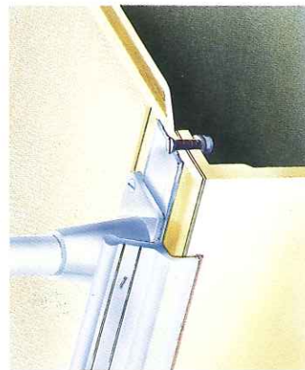
Le rail de fargue participe à la solidité de la liaison coque-pont.
